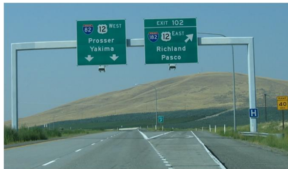
高速道路82、182の建設
