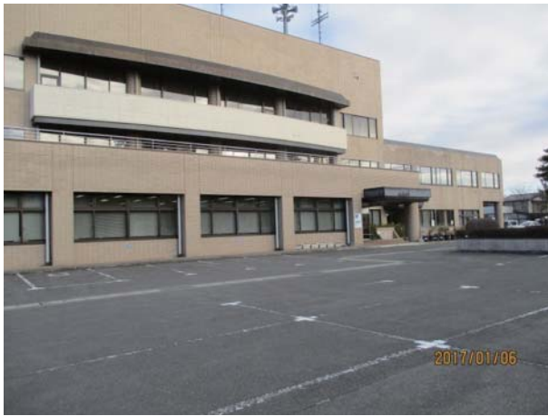
福島市役所飯野支所
