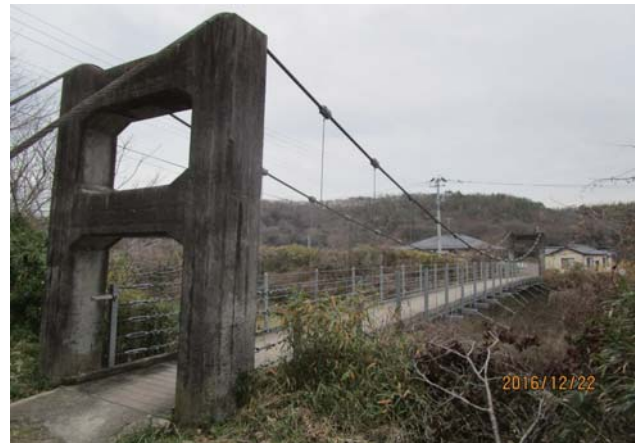
炭住近くの生活道路橋
