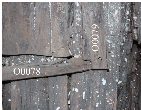
Fig. 6 梁・桁のおさまり詳細
